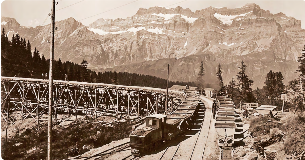
Zug-Verkehr auf Mettmen – beim Bau der Staumauer von 1929 bis 1931.
